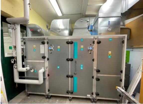
Abbildung 7: Wärmerückgewinnungs-Anlage (Foto Dominik Gruber)
