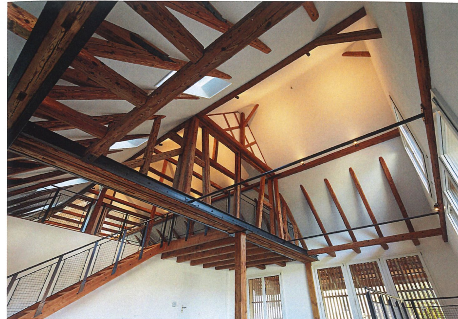
Umbau Deckenansicht Fotograf Alex Colle
