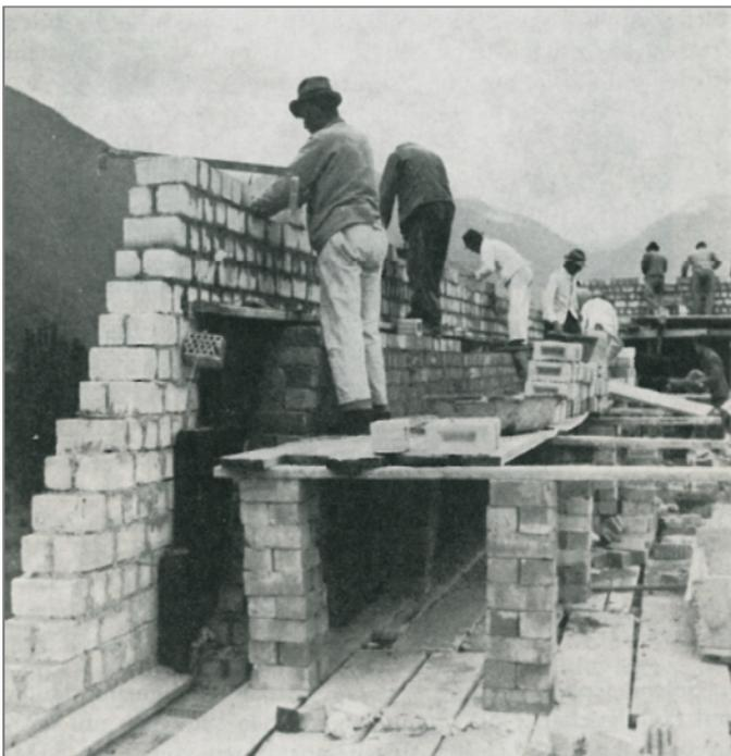
Errichtung einer Hausmauer mit Korkplatten-Isolierung 1945 (Buch „Wärme-Isolierung“ Hottinger/Imhof)
