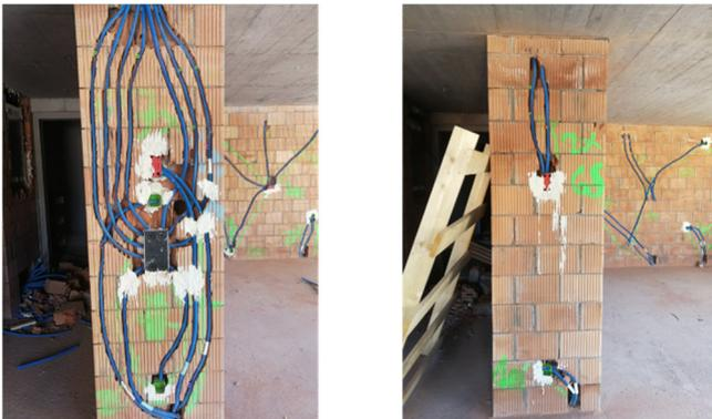
Herkömmliche Installation versus Funkschalter
