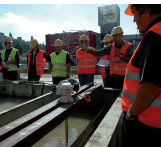
Die Abwasservorbehandlung auf der Baustelle A5 wurde kontinuierlich entwickelt und optimiert.
