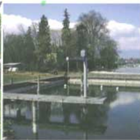
Die Mündung der Versoix vor ... und nach den Renaturierungsarbeiten.
