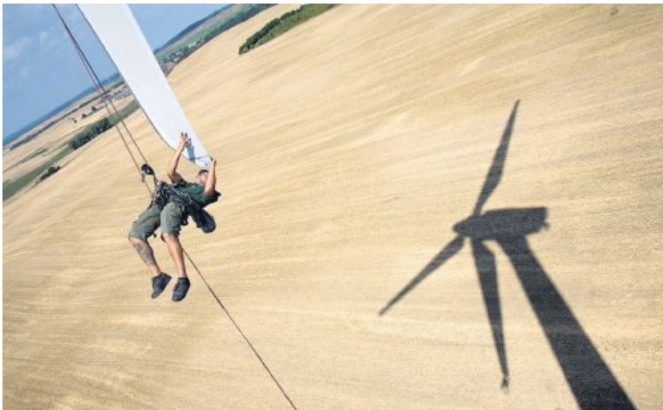
Im Einsatz für saubere Energie: Ein Kletterer prüft die Rotorhaut einer deutschen Windkraftanlage. Foto: Paul Langrock (Laif)
