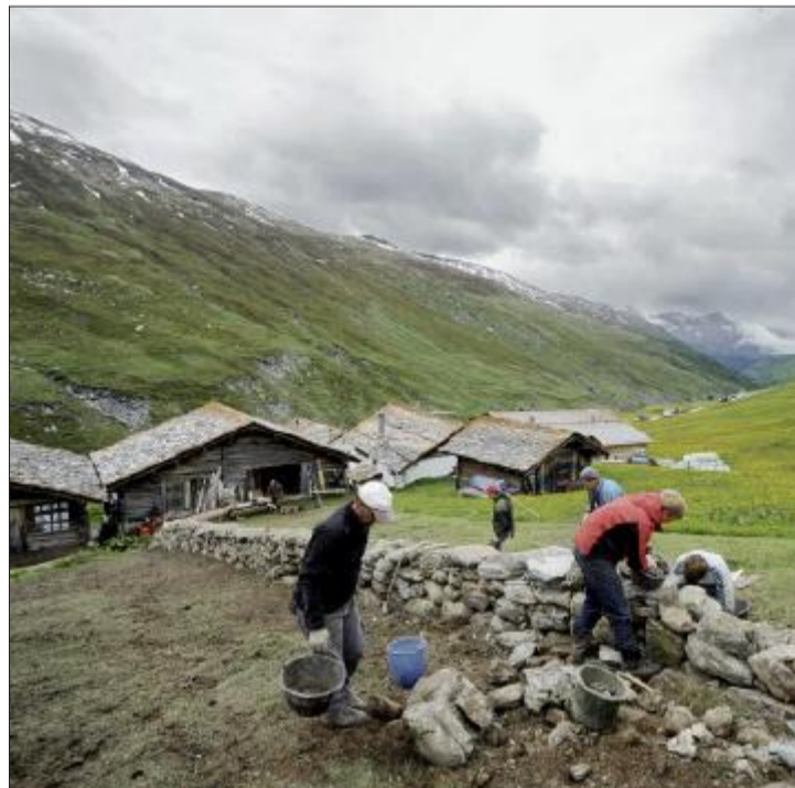
Aus Lesesteinhaufen entstehen neue Landschaftselemente im Hochtal Avers. (Bild: Reiner Schilling)
