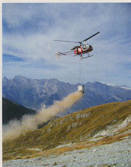
01 Die neue Richtlinie Hochlagenbegrünung soll die Qualität von Rekultivierungen im alpinen Raum erhöhen. Im Bild: Helikopter mit Saatgerät (Bild: M.Schwager)
