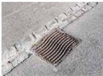
Abb. 5 Abgeschrägte Randschlüsse ermöglichen Kleintieren, die Fahrbahn gefahrlos zu verlassen und der Wasserabfluss ist weiterhin gewährleistet. Dieser Rost hat schmale Schlitz, welche die Gefahr für Kleintiere praktisch entschärft.
