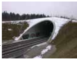
BE Birschwald Brücke über Bahn, Nordportal 11.02.2003
