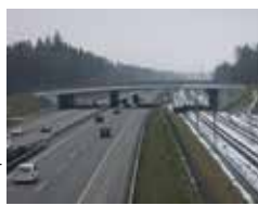
Neur-Ischlag Brücke, Südportal 11.02.2003
