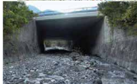
Brücke vor den Arbeiten, talseitige Ansicht
