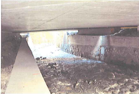
Neue Brücke und alte Wiederlagerwände, in Fliessrichtung
