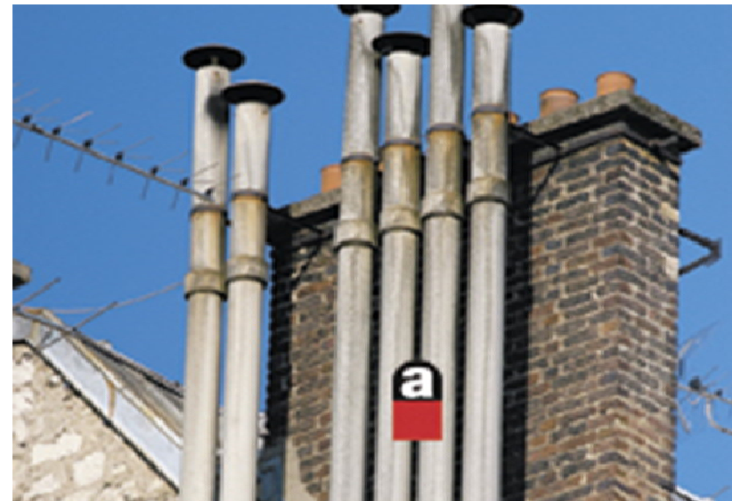
Tuyaux en fibrociment (fibre d'amiante)
