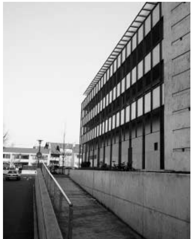
Behindertengerechte Bauweise: QP Leimenstrasse, Ettingen
